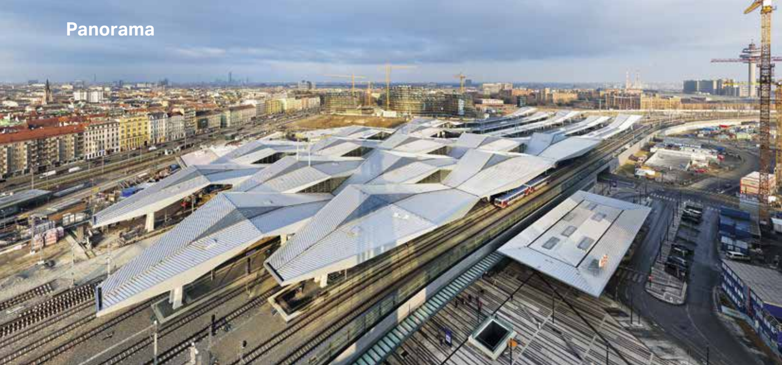
↑ Über den Bahnsteigen spannt sich ein gefaltetes Rautendach auf.
