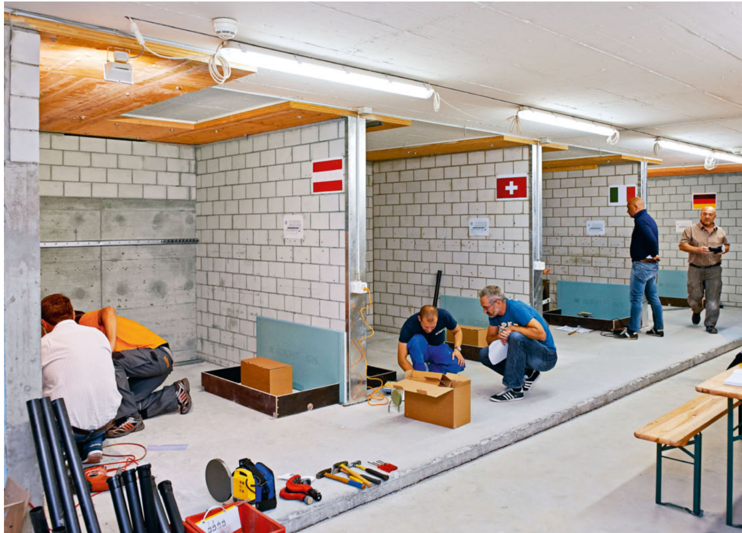
↑ Installateure und Fliesenleger aus vier verschiedenen Ländern installieren im bauphysikalischen Labor von Geberit Prototypen der neuen Geberit Duschrinne CleanLine.
